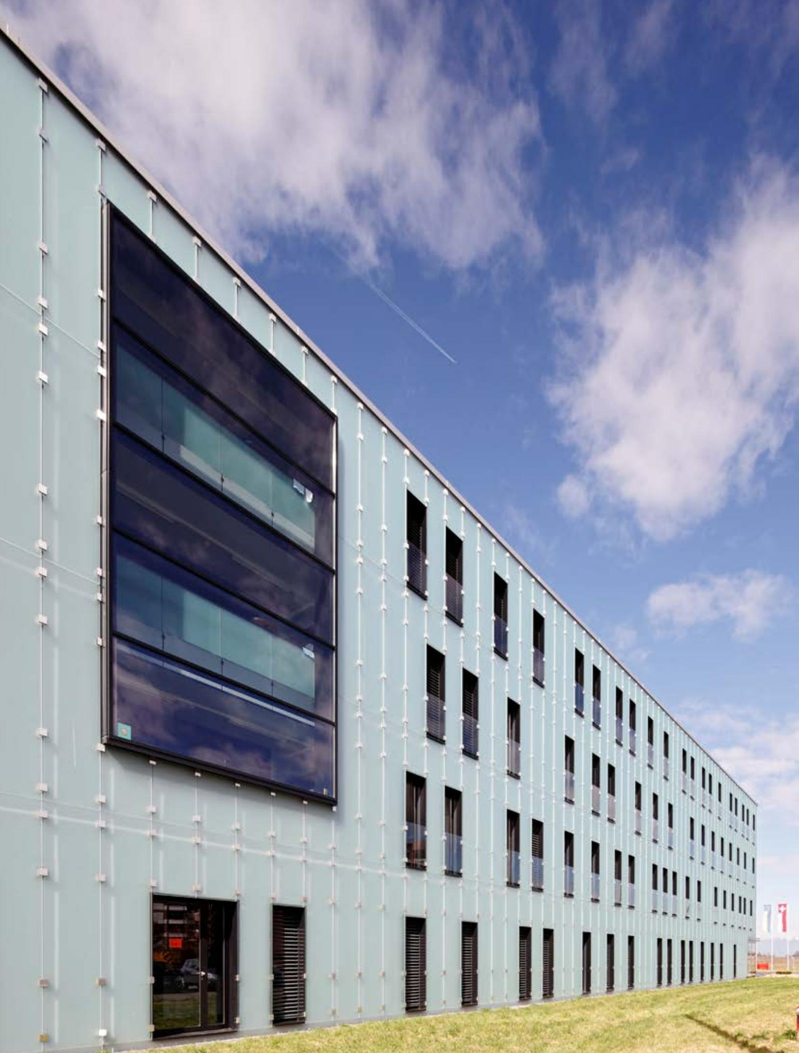
Wärmedämmte Fenster und Verglasungen einbruchhemmend mit Forster thermfix vario und Forster unico –
