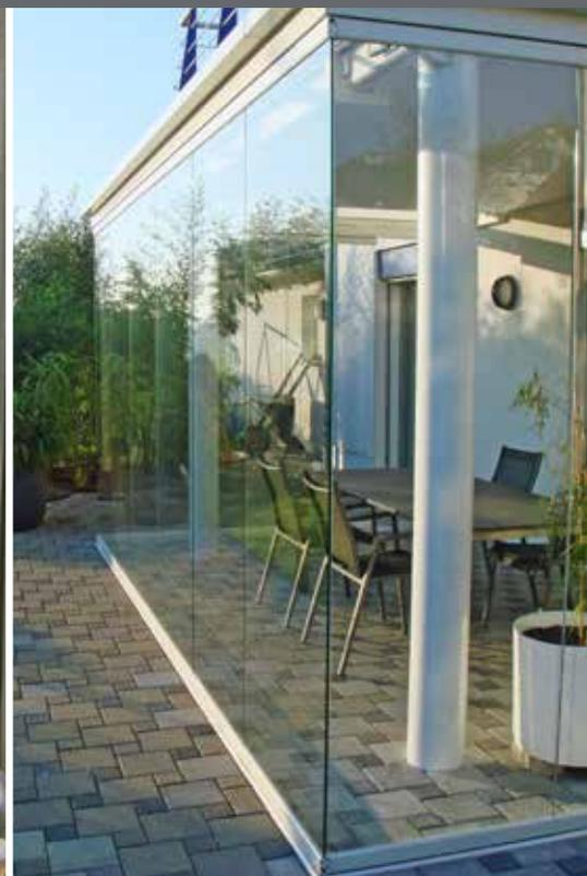
nucovista GG ist ein oben hängendes, nicht isoliertes Schiebe-/Drehsystem mit Einscheiben-Sicherheits-Glas (ESG) ohne vertikale Flügelprofile.
